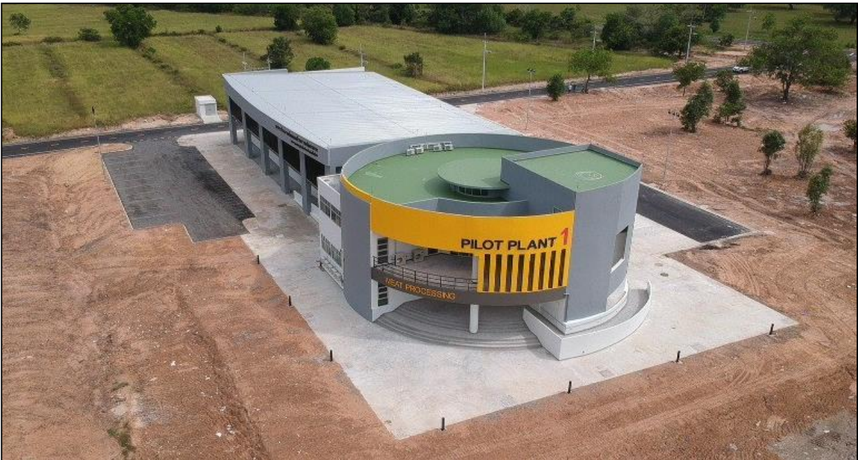
ภาพที่ ๓ ภาพจริงอาคารโรงงานต้นแบบด้านการแปรรูปผลิตภัณฑ์จากเนื้อสัตว์
